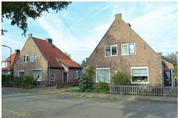
Overzicht van de twee kopwoningen (woningtype A) aan de oostzijde.
