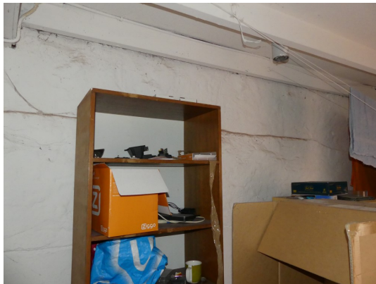
Het hoogteverschil in vloerniveau op de eerste verdieping in de richting van de Oudestraat. Het hoogteverschil wijst waarschijnlijk op een verschil in bouwphase en zou de plaats van de oorspronkelijke achtergevel kunnen markeren.
