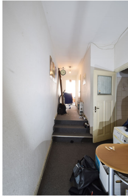
Het hoogteverschil in vloerniveau op de eerste verdieping in de richting van de Oudestraat. Het hoogteverschil wijst waarschijnlijk op een verschil in bouwphase en zou de plaats van de oorspronkelijke achtergevel kunnen markeren.
