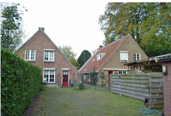
De achtergevels van Hoofdstraat 30-32 (links) en 34-36 (rechts).
