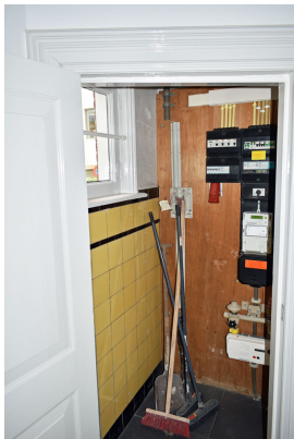
Wandtegels in het voormalige diensttoilet (nu meterkast 0.07).
