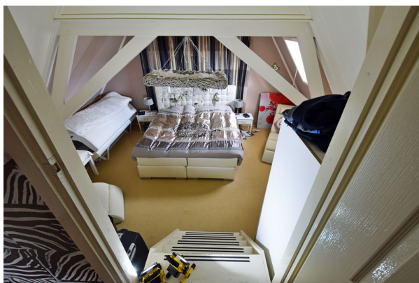
Kapconstructie van het bouwdeel linksachter.
