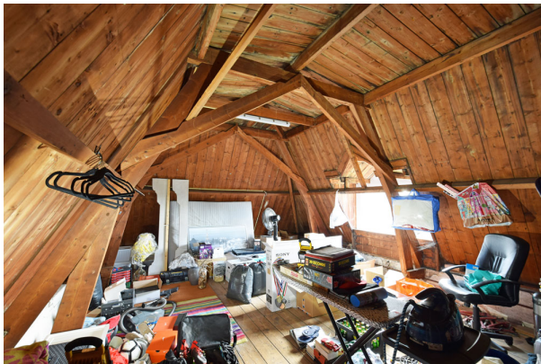
Kapconstructie van het verhoogde rechter bouwdeel.
