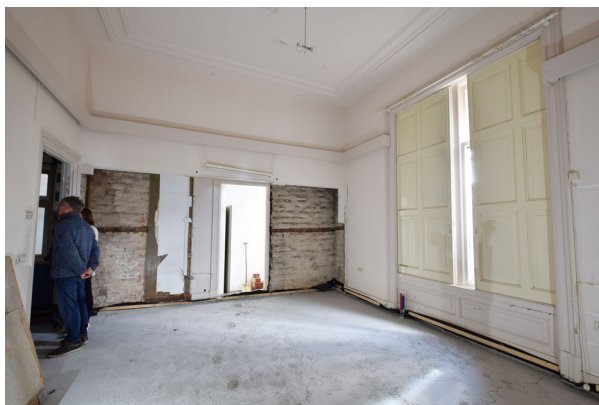
Kamer rechtsachter op de begane grond (0.16) met eenvoudiger stucplafond en schuifblinden.
