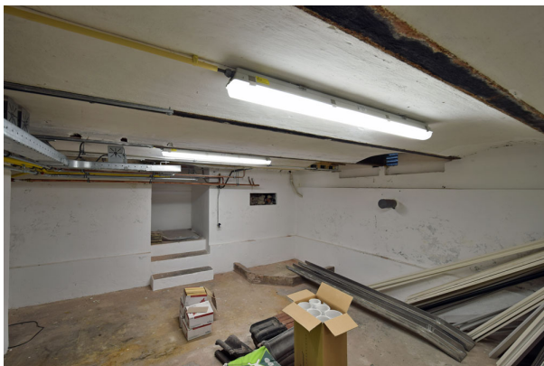
De kelder met troggewelven tussen ijzeren liggers. Rechtsachter zal een stookopstelling gestaan hebben.
