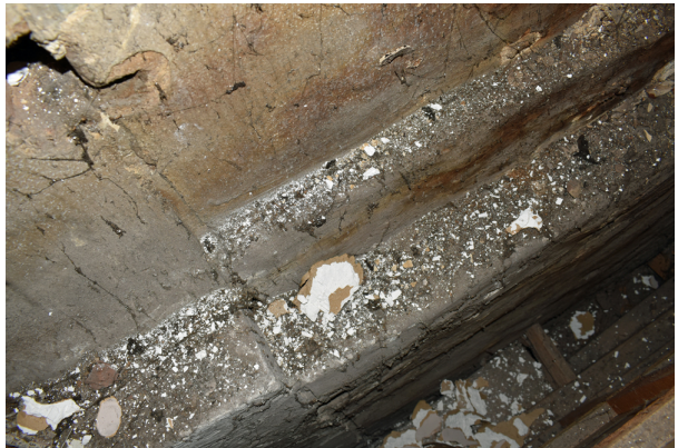
Via een klein kijkgat in de voorzetwand tegen de linker zijgevel op de verdieping is te zien dat de borstwering van het 14e eeuwse huis verhoogd is met een dunnere muur.
