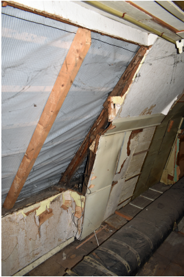
Gedeeltelijk nog afgetimmerde kreupele stijl tegen de borstwering van de linker zijgevel.
