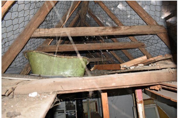
De rondhouten daksporen zijn in de nok voorzien van haanhouten.
