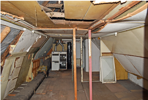
Gedeeltelijk nog afgetimmerde kreupele stijl tegen de borstwering van de linker zijgevel.
