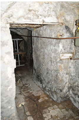
Doorgang tussen beide kelders, gezien vanaf de kelder van Meipootstraat 39. Opvallend is de enorme dikte van de scheidingsmuur die opgebouwd is uit twee afzonderlijke bakstenen muren.
