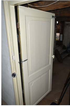
18e-eeuwse paneeldeur, herplaatst tussen de zolder en overloop van nr. 39.
