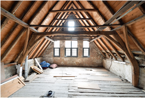
Overzicht van de kap van nr. 41 in de richting van de voorgevel. De kapconstructie is opgebouwd uit drie eiken dekbalkgebinten met flieringen die de daksporen dragen.
