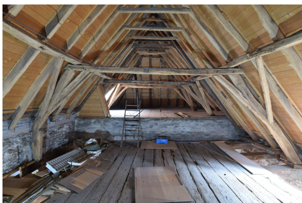
Overzicht van de eiken sporenkap van Meipoortstraat 39, ondersteund met vier eiken dekbalkgebinten in de richting van de achtergevel. De combinatie van eiken kaponderdelen en gehakte telmerken maakt een datering in de 16e eeuw aannemelijk.
