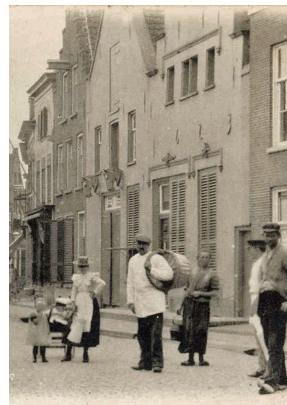
Ongedateerde foto (omstreeks 1900) van de voorgevels van Meipoortstraat 39-41. Te zien is dat nr. 39 niet alleen een hijsluik op zolder, maar ook een luikopening op de verdieping had (Collectie Streekarchivariaat De Liemers en Doesburg).
