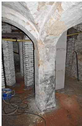
Loodrecht tussen de kolom en de muren zijn gordelbogen geslagen (op de voorgrond) die de kelder van Meipootstraat 41 in vier vakken met kruisgraatgewelven verdelen. Foto richting de zuidzijde, waarbij links op de achtergrond de oorspronkelijke toegang van en naar de straat te zien is.
