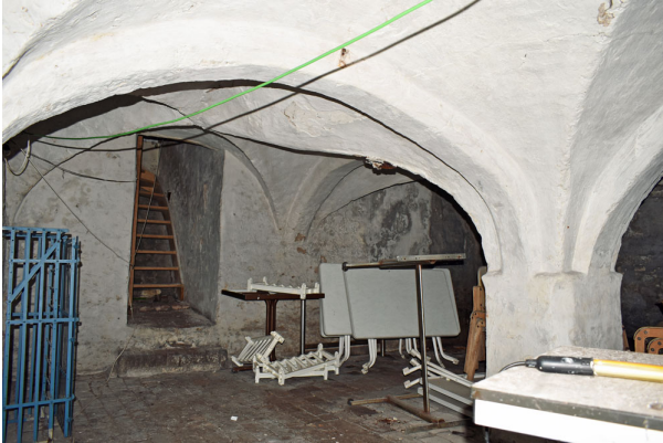
Overzicht van de kelder van Meipootstraat 41 richting het noorden. De gewelven worden centraal ondersteund door een gemetselde kolom.
