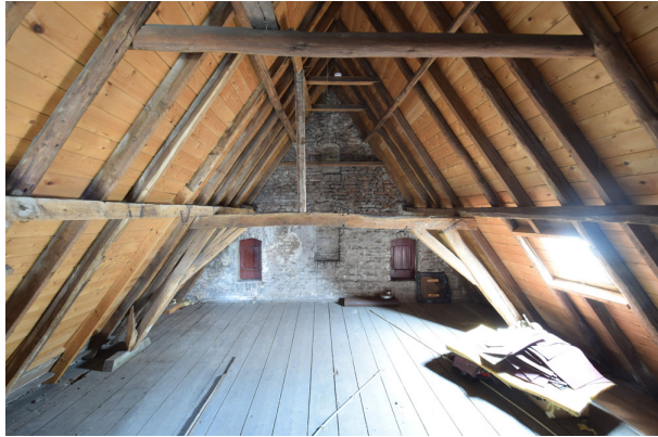
Overzicht van het achterste deel van de kapconstructie van nr. 41 in de richting van de achtergevel. Deze gevel is uitgevoerd als bakstenen tuitgevel met vlechtingen en is voorzien van vier luikopeningen (waarvan er twee dichtgezet zijn).
