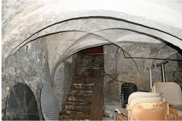
Loodrecht tussen de kolom en de muren zijn gordelbogen geslagen (op de voorgrond) die de kelder van Meipootstraat 41 in vier vakken met kruisgraatgewelven verdelen. Foto richting de zuidzijde, waarbij links op de achtergrond de oorspronkelijke toegang van en naar de straat te zien is.
