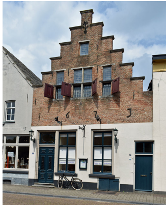
De trapgevel van nr. 41 is gedateerd 1623. Mogelijk is het huis inclusief casco en gevels in dat jaar in één bouwfase vernieuwd.
