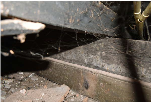
De zolderbalklaag van Meipootstraat 41 bestaat uit een samengestelde balklaag met moer- en kinderbinten.
