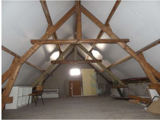
Naast de bouwnaad in de gordingen is het bouwfaseverschil tussen het voorste deel van de kap (1915) en het achterste deel van de kap (1945) te zien in de toepassing van hergebruikt hout bij het laatste spant. Door de materiaalschaarste tegen het eind of net na de oorlog in combinatie met de beschikbaarheid van veel sloophout in het getroffen Zutphen is een verklaring voor de toepassing van hergebruikt hout.
