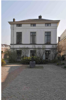
In Nederland staan veel vergelijkbare, eclectisch vormgegeven villa's uit het derde kwart van de 19e eeuw. Op deze foto een villa aan de Van Asch van Wijckskade in Utrecht, eveneens met vensters in het mezzanino.
