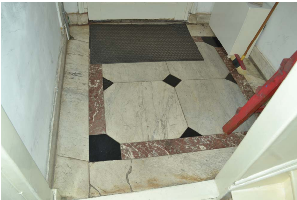
In entreeruimte is in 1876 een marmeren vloer gelegd, die niet doorloopt in de hal.
