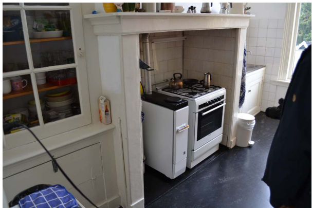
Op de verdieping is in de keuken een ensemble van glaskast, keukenschouw en aanrecht (met vernieuwd aanrechtblad) bewaard gebleven.
