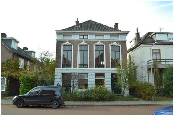
Overzicht van de voorgevel.
