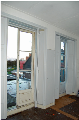
Dubbele glasdeuren in de achtergevel ter plaatse van het meest oostelijke vertrek op de verdieping. De van blinden voorziene deuren zijn zeer zorgvuldig gedetailleerd en verkeren nog geheel in de oorspronkelijke staat.
