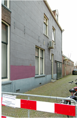
Zijgevel van Thorbeckegracht 81/Kanonsteeg 1. Het gehele gevelvlak is waarschijnlijk bij de vernieuwing van het achterhuis kort voor 1861 gepleisterd om de aansluiting van oud en nieuw metselwerk te verbergen. Het voorste deel van de gevel is voorzien van schijnvoegen, het achterste deel is geheel vlak.
