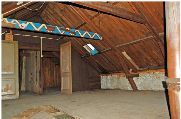
Overzicht van de zolder. De gordingen worden ondersteund door Hollandse spanten met kreupele stijlen.
