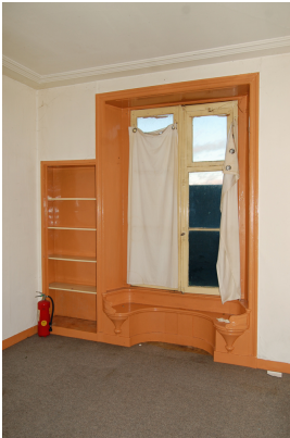
Venster in de achtergevel van het meest westelijke vertrek op de verdieping met aansluitend een oorspronkelijk van een behangen deur voorziene inbouwkast.
