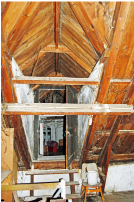
Doorgang via de zakgoot met de zolder van het voorhuis.
