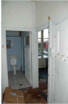
Gang in de richting van de achtergevel. Het toilet aan het eind van de gang was oorspronkelijk een stuk ondieper, zoals blijkt uit de aansluiting van de deurkozijnen en het oorspronkelijke tegelwerk dat deels bewaard bleef.
