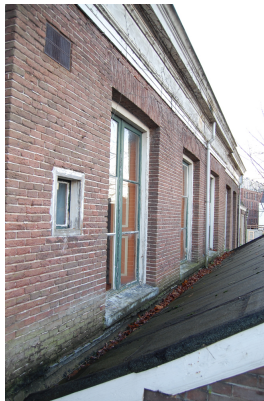
Overzicht van het middelste deel van de gevel met geheel links een later ingehakt venster van het achterliggende privaat/toilet.
