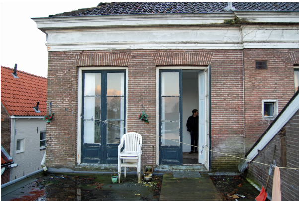
Oostelijke deel van de achtergevel van Kanonsteeg 1. De dubbele glasdeuren behoren tot de oorspronkelijke opzet en komen nu uit op het platte dak van een in 1950 gerealiseerde stal/berging. Oorspronkelijk was hier (en aan het andere eind van de gevel) een balkon aangebracht.
