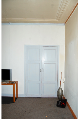
De dubbele deuren van een in het voorhuis uitgebouwde inloopkast waren oorspronkelijk opgenomen in de wandbespanning. Later zijn deze omgedraaid zodat de van panelen voorziene achterzijde in het zicht kwam.
