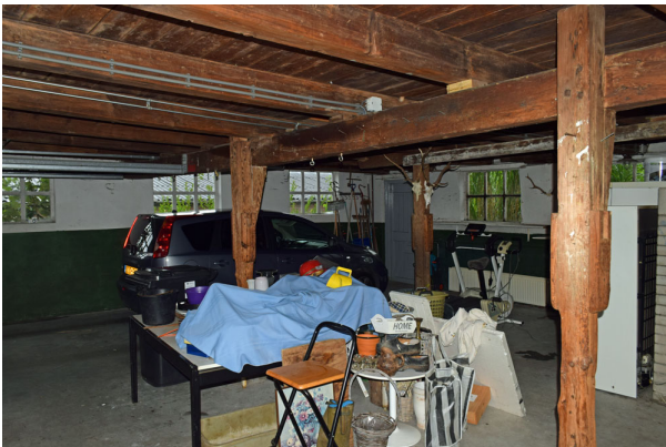
Overzicht van het westelijk deel van het bedrijfsgedeelte. De eenvoudige naalddhouten balklaag wordt ondersteund door een (waarschijnlijk later aangebrachte) onderslagbalk die gedragen wordt door staanders van naalddhout.
