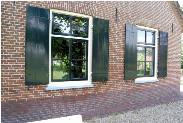
De twee westelijke vensters op de begane grond in de voorgevel. In 1992 zijn alle schuifvensters gemoderniseerd met nieuwe ramen en vaste kalven.
