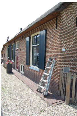
Voorste deel van de linker zijgevel. In 1992 is ter hoogte van de opkamer een nieuw venster ingehakt.
