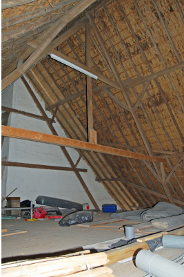
Overzicht van de kaspanten boven het bedrijfsgedeelte.
