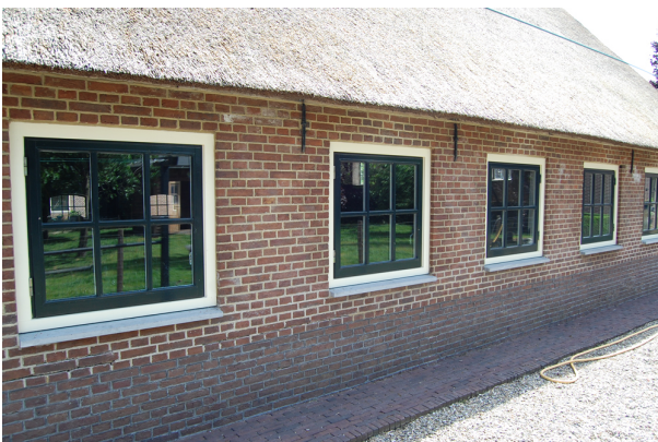
Vernieuwde vensters in de rechter zijgevel van het bedrijfsgedeelte.
