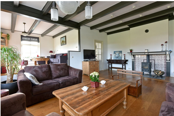
Overzicht van het centrale woonvertrek op de begane grond met links de verbrede en opengebroken opkamer. De schouw tegen de brandmuur dateert waarschijnlijk nog uit de bouwtijd.
