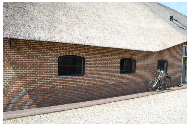
De linker zijgevel van het bedrijfsgedeelte is inclusief de deur uiterst rechts op de foto geheel vernieuwd. daarbij is de indeling van de stalvensters aangepast.
