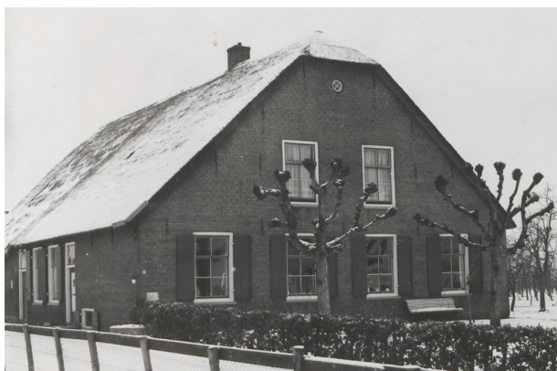
Foto van de voorzijde van de boerderij uit 1987. Bij de verbouwing enkele jaren later zouden de oorspronkelijke schuiframen vervangen worden door nieuwe boven- en onderramen gevuld met isolatieglas.
