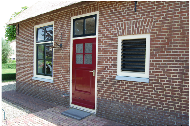
Overzicht van het voorste deel van de de rechter zijgevel ter hoogte van de voormalige kaaskamer. In deze gevel zijn in 1992 een deur met bovenlicht en een venster ingehakt. De bestaande ventilatieopening met persiënnes bleef daarbij bewaard.
