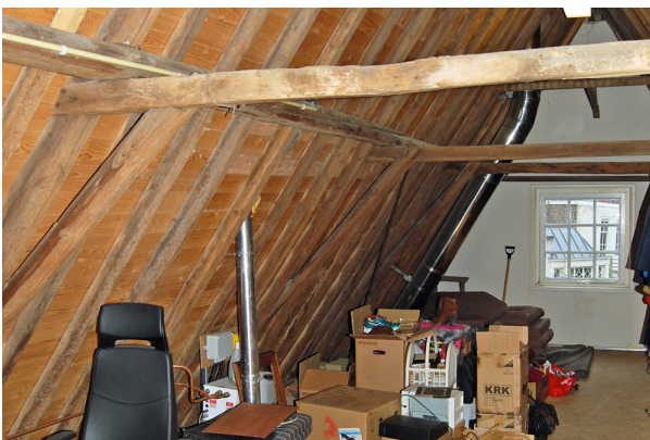
De A-spanten aan de achterzijde zijn voorzien van haanhouten die bestaan uit hergebruikte eiken daksporen.
