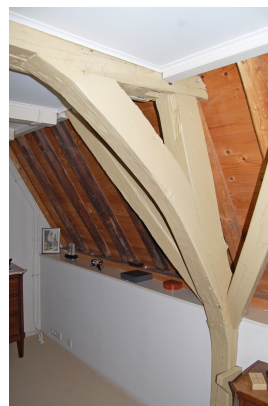
De korbelen van de eiken kromstijlgebinten zijn aan de onderzijde met een gespijkerde verbinding aan de stijlen verbonden. Aan de bovenzijde zijn de korbelen in de dekbalken gepend.
