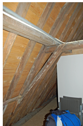
De korbelen van de eiken kromstijlgebinten zijn aan de onderzijde met een gespijkerde verbinding aan de stijlen verbonden. Aan de bovenzijde zijn de korbelen in de dekbalken gepend.
