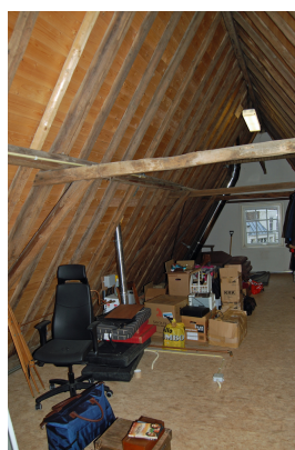
Overzicht van de vliering. De kapconstructie op dit niveau is opgebouwd uit rondhouten daksporen en A-spanten.
