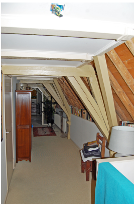
Overzicht van de kapgebinten aan de rechter zijde op de zolder.
