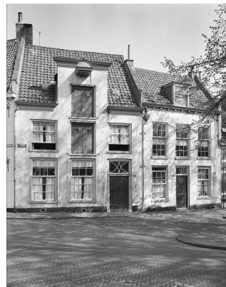
De voorgevel van Havik 2 na de restauratie, gefotografeerd in 1961 (beeldbank RCE).
