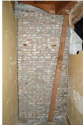
De doorgang achter de middelste deur is dichtgezet na de plaatsing van de huidige verdiepingstrap.
