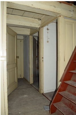
Overzicht van de indeling op de verdieping van het voorhuis. De kamers zijn nog voorzien van 19e-eeuwse paneeldeuren. Rechts de zoldertrap.
