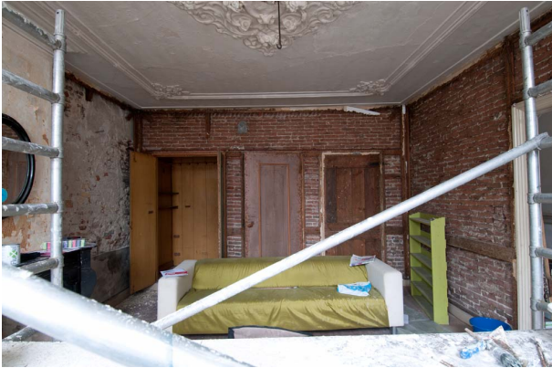
Zicht op de kastenwand van het vertrek aan de straatzijde. Achter de middelste deur bevond zich oorspronkelijk een doorgang naar de zuidelijke kamer van het achterhuis.
