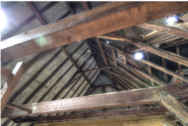
Zicht op het bovenste deel van de kapconstructie van het voorhuis. Ter hoogte van de gebinten zijn de sporenparen voorzien van geschoorde haanhouten.
