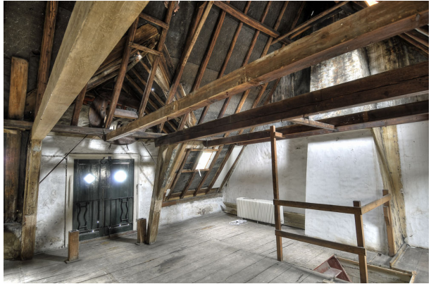
Overzicht van de kapconstructie van het voorhuis, in de richting van de voorgevel. Waarschijnlijk vond in de tweede helft van de 17e-, of in het begin van de 18e eeuw nieuwbouw van het voorhuis plaats. De hijsvoorziening is later tot stand gekomen.
