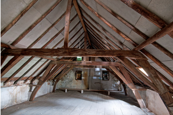
Overzicht van de kapconstructie van het achterhuis, in de richting van de achtergevel.
