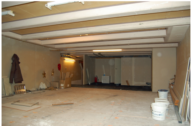
Overzicht van de enkelvoudige balklaag van de verdieping, vanuit de winkel van nr 40 (foto 11-2009).
