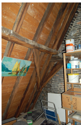
Bovenste deel van gebint nr 6 aan de achterzijde. De windschoren zijn om-en-om aangebracht en aan de bovenzijde met een pen-en-gat verbinding met de flieren verbonden.
