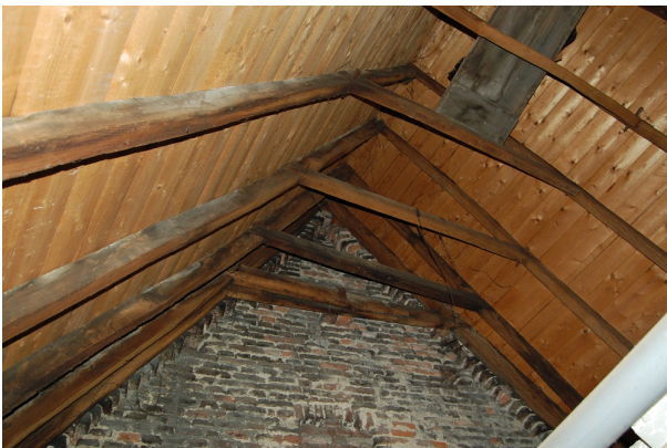
Eiken sporengespannen van het hoofdhuis ter hoogte van de topgevel aan het Koningsplein. Van het laatste gespan is het haanhout dubbel uitgevoerd.
