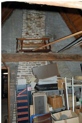
Overzicht van de 18e eeuwse zolderbalklaag van het voorhuis. Deze vloer is aan het eind van de 18e eeuw vernieuwd en daarbij een stuk hoger aangebracht.
