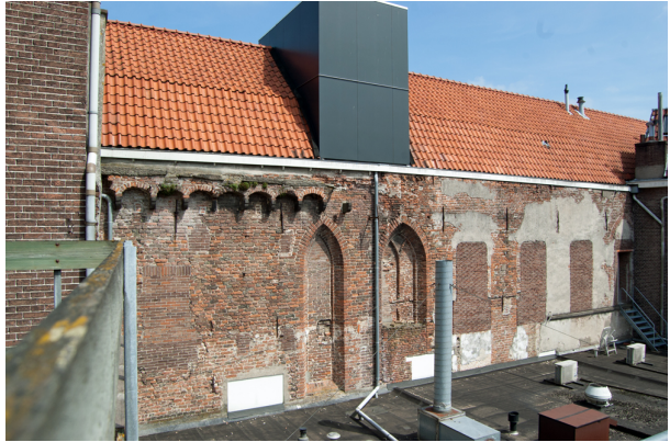
Achtergevel van de voormalige 14e eeuwse ziekenzaal aan de Gasthuisstraat. In deze gevel zijn de bouwsporen te zien van een aantal grote spitsboogvensters. Het boogfries aan de linkerzijde met daarop de restanten van een goot van Drachenfels trachiet heeft bij een nu verdwenen huis behoord.
