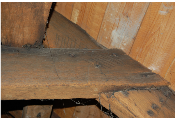
Eiken sporengespannen van het hoofdhuis ter hoogte van de topgevel aan het Koningsplein. Van het laatste gespan is het haanhout dubbel uitgevoerd.
