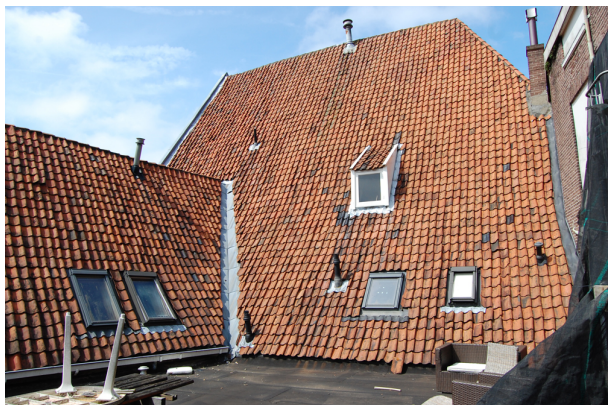
Achterzijde van het hoofdhuis met de aankapping die aansluit op het platte dak van de uitbreiding van de winkel van nr 40 uit 1988.
