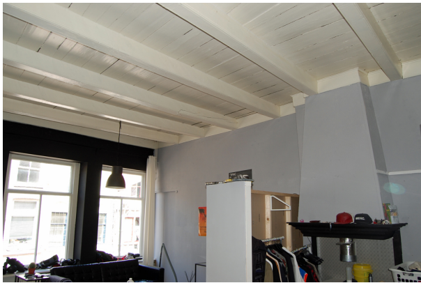
Overzicht van de 18e eeuwse zolderbalklaag van het voorhuis. Deze vloer is aan het eind van de 18e eeuw vernieuwd en daarbij een stuk hoger aangebracht.
