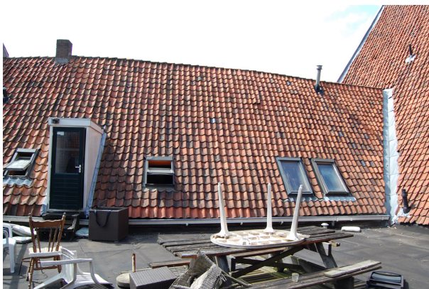
Noordelijk deel van de achterzijde van het achterhuis.
