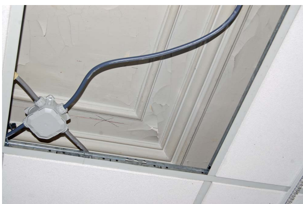
Detail van het lijstwerk van het stucplafond uit 1881 in het vertrek linksvoor op de begane grond.
