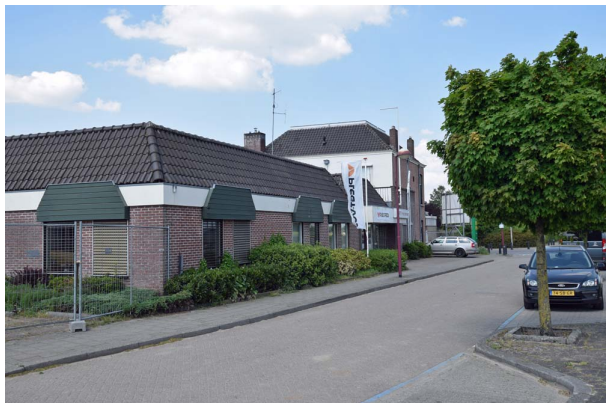
Overzicht van de achterzijde aan De Opgang.
