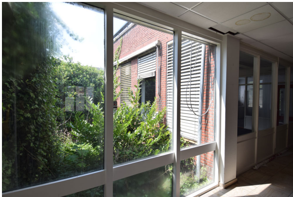
Achtergevel van de aanbouw uit 1947.
