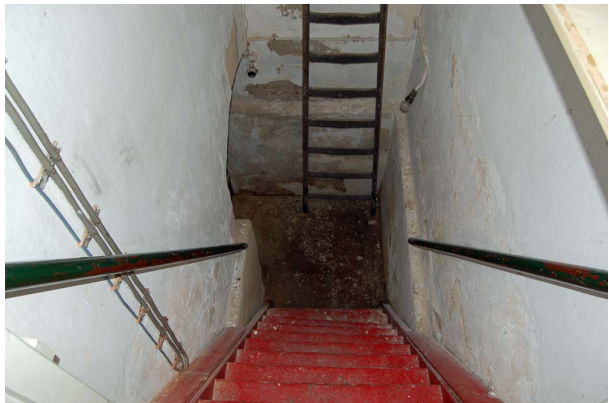
In de gang op de begane grond bevindt zich naast de verdiepingstrap de toegang tot de kelder.
