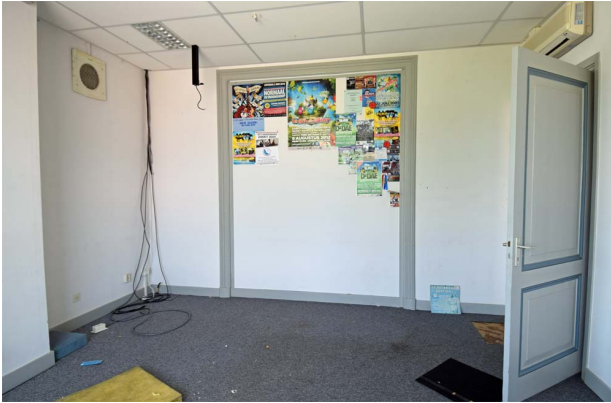
Het vertrek linksvoor op de verdieping. Dit vertrek en het vertrek hierachter waren oorspronkelijk ingedeeld als kamers-en-suite. De doorgang is later dichtgezet.
