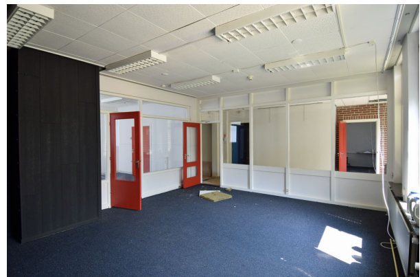
Huidig interieur van de aanbouw uit 1947.
