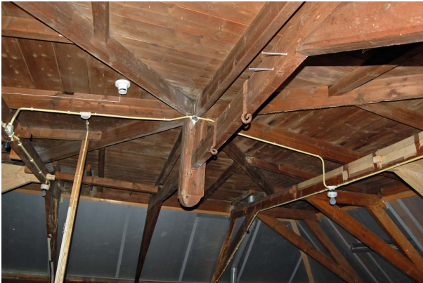
Detail van de koningsstijl in de kap.
