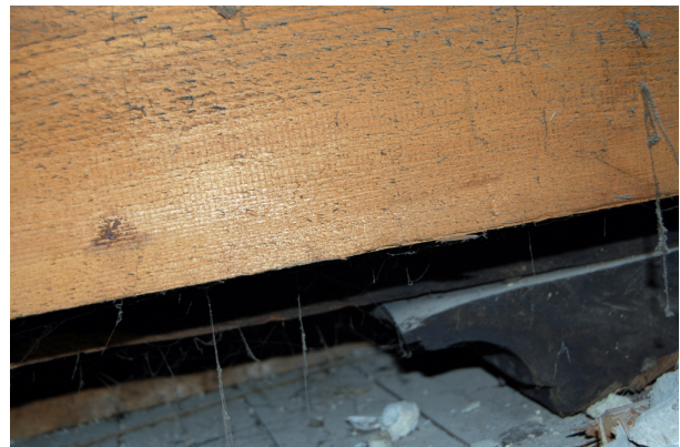
Onder een moerbalk van de verdiepingsbalklaag is boven de huidige toiletten nog net een deel van een console met een ojiefprofiel waar te nemen.
