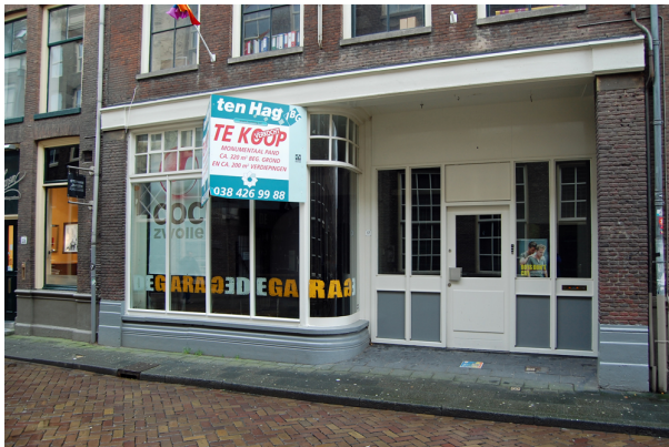
Onderpui, aangebracht bij de verbouwing van de begane grond tot garagebedrijf in 1920. Rechts van de etalage was via een onderdoorgang het achterterrein toegankelijk met auto's.
