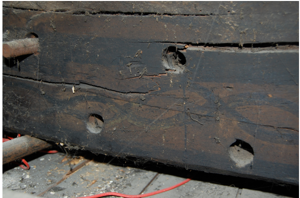
Deel van de oplegging van een moerbalk van de verdiepingsvloer aan de voorzijde. Onder de balk is een sleutelstuk aangebracht, de tognagelgaten behoren bij een verdwenen korbeel.
