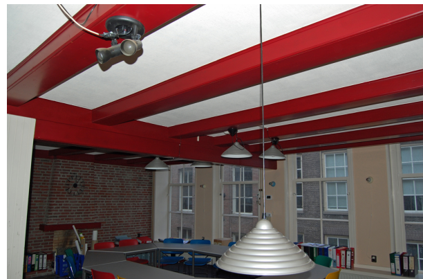
Overzicht van het vertrek aan de voorzijde op de verdieping. De dragende scheidsmuur is vervangen door een stalen balk en de houten balken van de zoldervloer zijn later omtimmerd.
