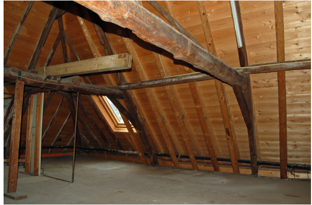
Overzicht van het achterste deel van de kapconstructie. De reparaties uit 2001 zijn goed te herkennen aan de lichtere houtsoort. De hijsbalk aan de achterzijde is waarschijnlijk in 1920 aangebracht ten behoeve van het garagebedrijf.
