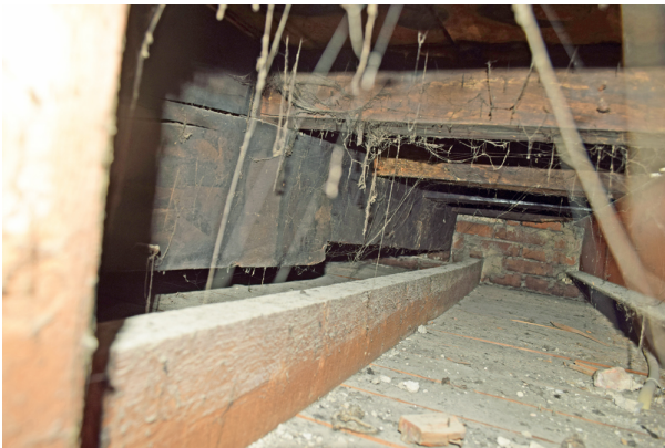
Gedeelte van de 14e of 15e eeuwse samengestelde verdiepingsbalklaag. De moerbalk wordt halverwege het huis ondersteund door een muur.
