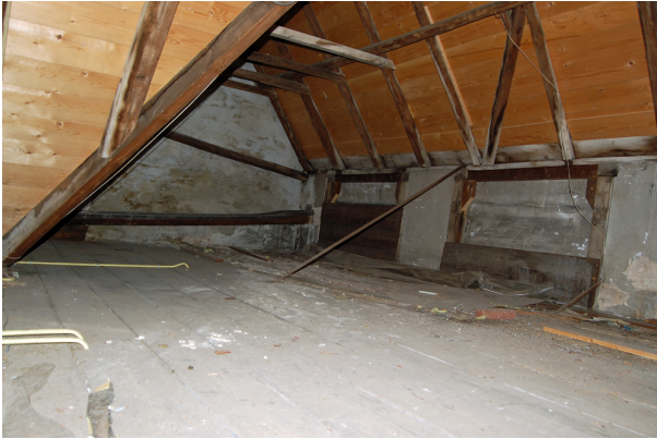
Rondhouten kapconstructie van het dwarskapje achter de voorgevel. De schuifvensters op de zolderverdieping kunnen omhoog geschoven worden tot achter de zolderborstwering.
