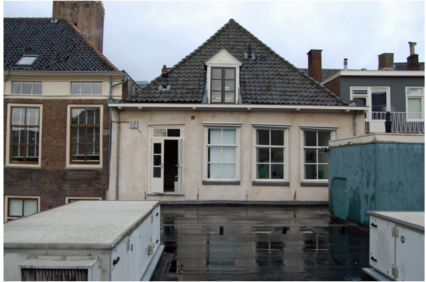
Achtergevel van het hoofdhuis aan de Kamperstraat vanaf het dak van de aanbouw aan de achterzijde.
