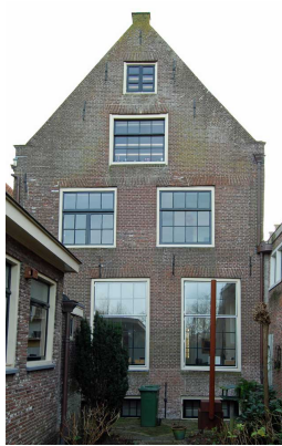
Achtergevel van Voorhaven 150.
