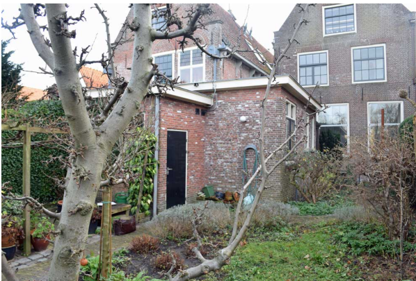
Overzicht van de noordzijde van de aanbouwen. Het schuurtje is voor zover zichtbaar geheel in nieuwe steen opgetrokken, terwijl in de keuken/bijkeuken ouder materiaal is hergebruikt.
