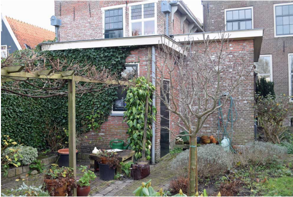
Noordgevels van de schuur en de bijkeuken. In de kopgevel van de bijkeuken is een toegang dichtgemetseld.
