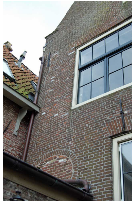
Linker deel van de achtergevel met op de verdieping een bouwspoor van een (secundaire) dichtgezette deuropening.
