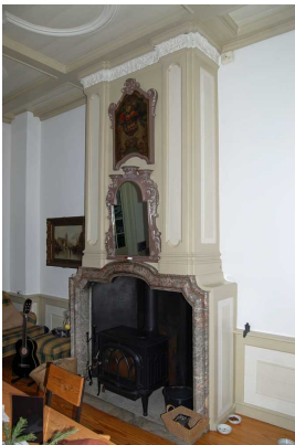
Schouw in de achterkamer op de begane grond in Lodewijk XIV stijl. De betimmering van het bovenste deel van de schouw sluit goed aan bij het in brede vakken betimmerde plafond. Opvallend is dat de marmeren onderbouw wat te breed lijkt om goed aan te kunnen sluiten op de bovenbouw.
