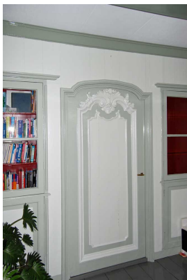
Secundair geplaatste deur in de voorkamer op de verdieping, gedecoreerd met uitbundig rococo snijwerk.
