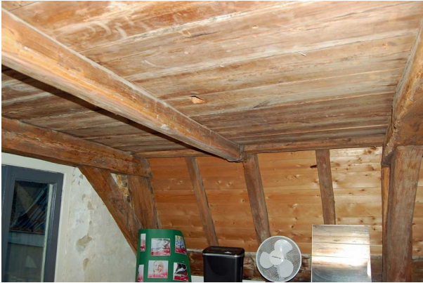
Constructie van de vlieringvloer van het rechter huis in de vorm van grenen tussenhangbalken.
