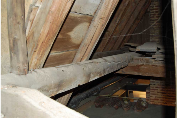
In de kap van het linker huis wordt een rookkanaal ondersteund door een secundair gebruikte spil van een spiltrap.
