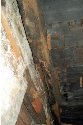
Strijkbalk tegen de achtergevel van de verdiepbingsbalklaag van nummer 9. In het midden heeft deze balk een uitsparing ten behoeve van een rookkanaal.
