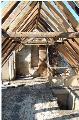
Achterste deel van de linker muur van nummer 7 op de tweede verdieping. De nis rechts markeert de hoogte van de voormalige zolderborstwering voor de verhoging van dit huis.
