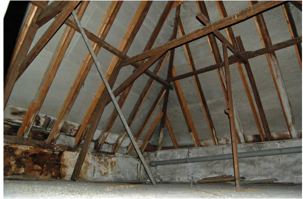
Rondhouten sporenkap van nummer 9, verstevigd met A-spanen met kreupele stijlen.
