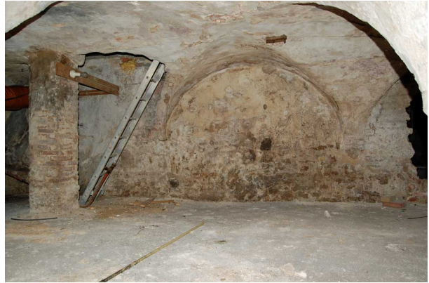
Kelder met kruisgewelven onder nummer 9 in de richting van de gemeenschappelijke bouwmuur met nummer 7.
