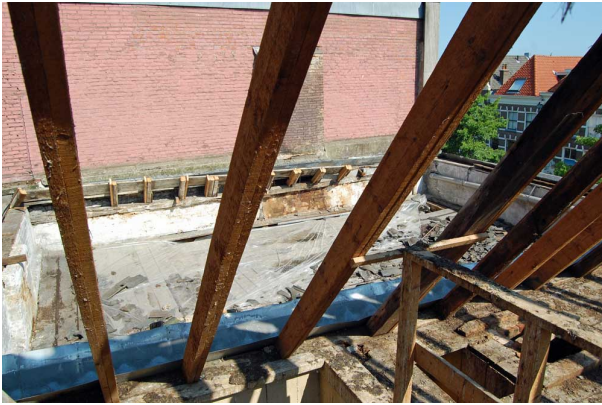
Zoldervloer van nummer 9 na de sloop van de kapconstructie.
