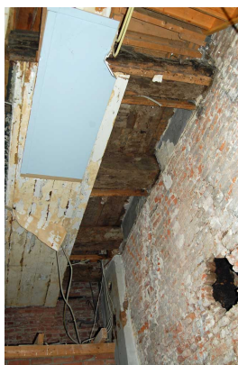
Oplegging van de enkelvoudige verdiepingenbalklaag van nummer 7 in de linker muur.
