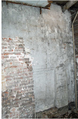
Achterste deel van de linker muur van nummer 7 op de tweede verdieping. De nis rechts markeert de hoogte van de voormalige zolderborstwering voor de verhoging van dit huis.
