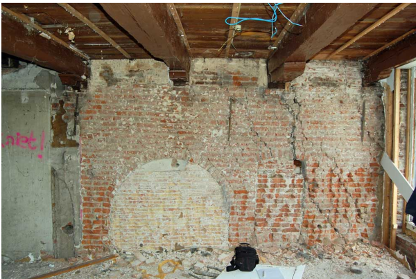
Strijkbalk tegen de achtergevel van de verdiepbingsbalklaag van nummer 9. In het midden heeft deze balk een uitsparing ten behoeve van een rookkanaal.
