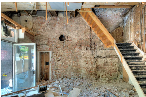
Overzicht van de linker muur van nummer 7 op de begane grond met centraal de contouren van een grote schouw.
