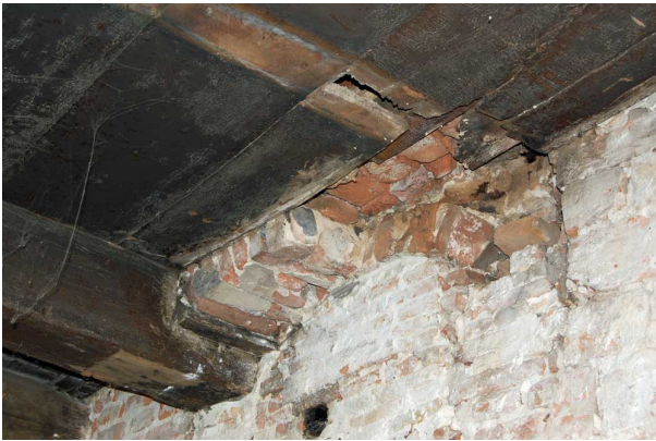
Haardgewelf tegen de rechter muur van nummer 9 gemetseld ter hoogte van de verdiepingvloer.
