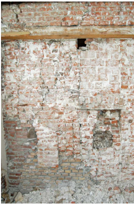
In het voorste deel van de gemeenschappelijke bouwmuur op de verdieping is een dichtgemetseld kloostervenster opgenomen.
