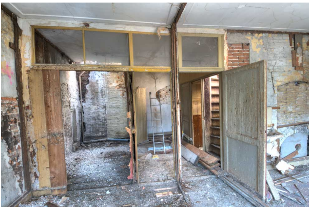
Overzicht van de tweede verdieping van nummer 7 in de richting van de achtergevel.
