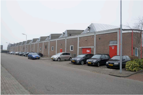
Foto van de linker zijgevel van de voormalige schoenenfabriek, met zicht op de dakconstructie met lichtstraten.
