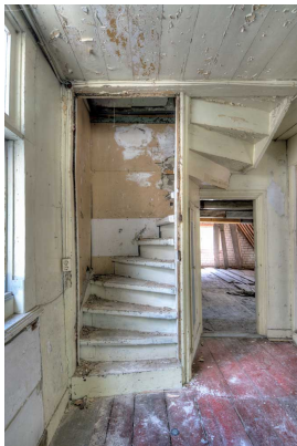
De trap van de verdieping naar de zolder is het bovenste deel van een zeventiende-eeuwse spiltrap. De zware treden zijn in de spil gepend.
