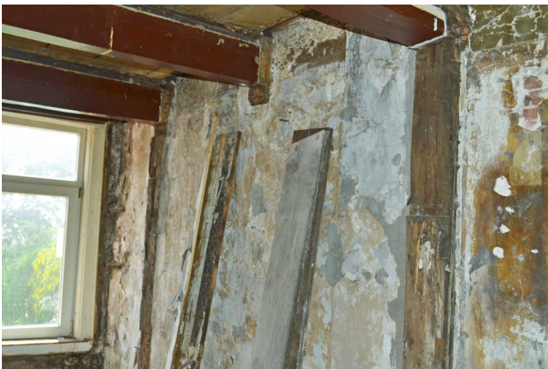
Detail van de balklaag en muurstijlen op de verdieping in de linker bouwmuur.
