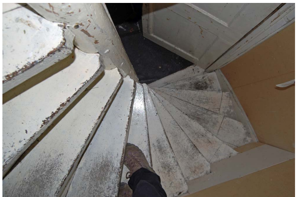
Bovenaanzicht van de spiltrap.
