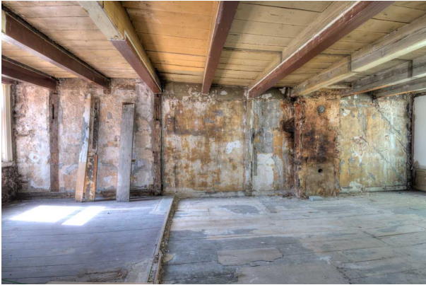
HDR foto van het houtskelet met tussenbalken op de verdieping. De korbelen van het houtskelet zijn allemaal verdwenen, de muurstijlen bleven bewaard.
