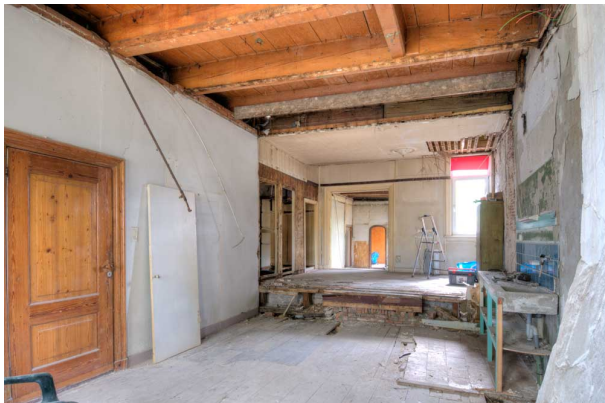
HDR foto van de begane grond in de richting van de opkamer.
