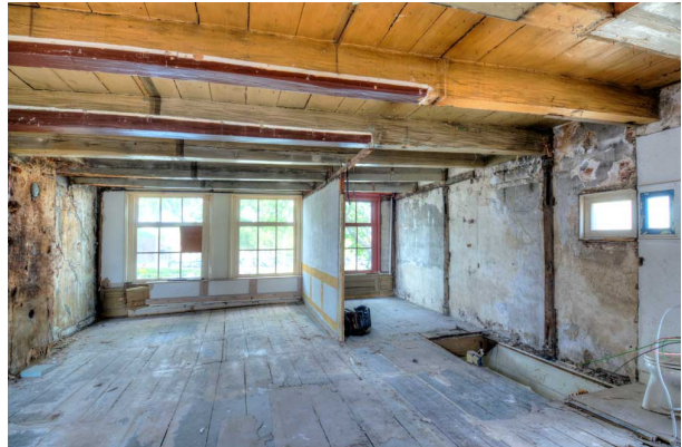
HDR foto van de verdieping in de richting van de Hoogstraat.
