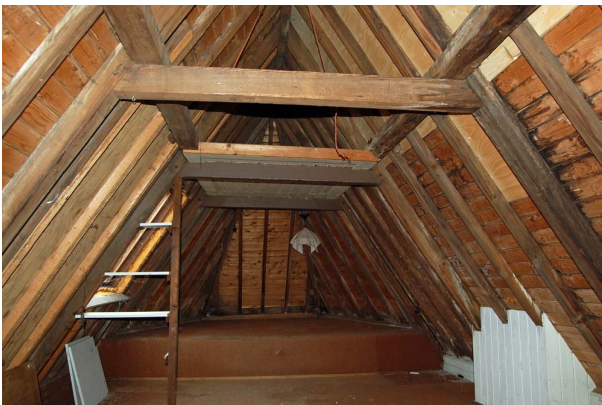
Overzicht van de kapconstructie van de achterste aanbouw.
