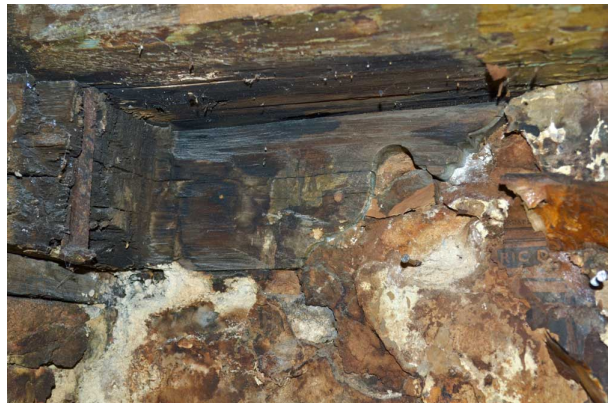
Links naast de schouw op de verdieping werd tijdens het veldwerk een fragment van een weggezaagde console aangetroffen. Het olijfprofiel is nog duidelijk zichtbaar. Uit de vergelijking met elders aangetroffen gedateerde voorbeelden volgt een datering in het eerste kwart van de zeventiende eeuw.
