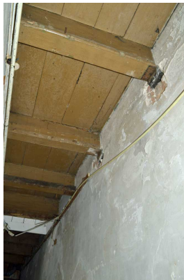
De begane grond heeft geen houtskelet, maar een enkelvoudige balklaag met bij de oplegging eiken consoles. De consoles zijn later vrijwel volledig afgezaagd.
