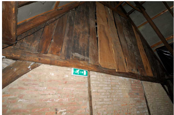
Ter hoogte van gebint nummer 3 is op zolderniveau een scheidingswand aangebracht waarvan het bovenste deel met vertikaal eiken beschot is uitgevoerd.
