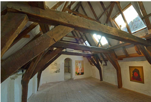
Overzicht van de kapconstructie van het noordelijke deel van Het Langhuis.
