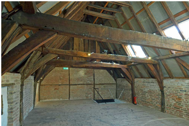
Overzicht van de kapconstructie van het zuidelijke deel van Het Langhuis.
