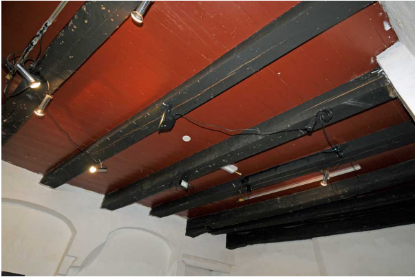
Alternierende eiken zolderbalklaag van het noordelijke deel van Het Langhuis.
