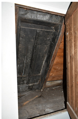
Een luikje in de kap maakte onderhoud aan de buitenzijde van het dak mogelijk.
