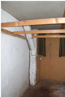
Naalddhouten gebintstijl met korbeel in de bedrijfsruimte tegen de scheidingsmuur met de woning.
