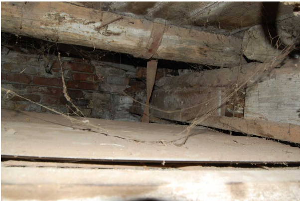
Detail van de balklaag van de aangebouwde bedrijfsruimte aan de achterzijde.
