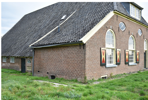
Een deel van de voorgevel en linker zijgevel van de boerderij.
