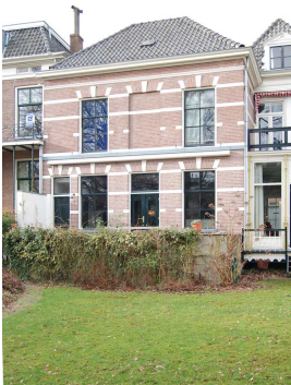
Huidige achtergevel van het achterhuis. De gevelindeling van de begane grond is tot stand gekomen bij de restauratie van 1978.
