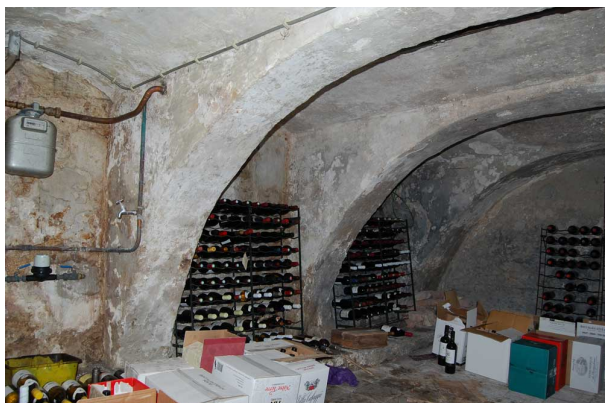
Zeventiende-eeuwse kelder onder het voorhuis. Het gewelf is opgebouwd uit gordelbogen waar tussen troggewelfjes aangebracht zijn.
