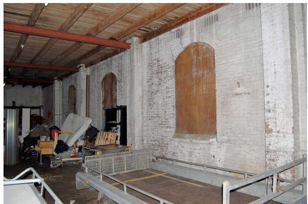
Interieur van de in 1950 gerealiseerde aanbouw met rechts de zijgevel van de smederij uit 1913 met daarin opgenomen drie gietijzeren vensters.
