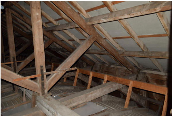
Overzicht van de kapconstructie.
