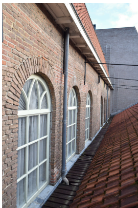
Overzicht van de vensterreeks in de zuidgevel van het kerkgebouw. Het metselwerk is in het midden duidelijk onderbroken met een bouwnaad.
