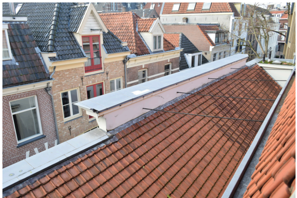
Overzicht van het dak van de voorbouw aan de Wolweverstraat.
