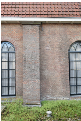
Overzicht van de vensterreeks in de zuidgevel van het kerkgebouw. Het metselwerk is in het midden duidelijk onderbroken met een bouwnaad.
