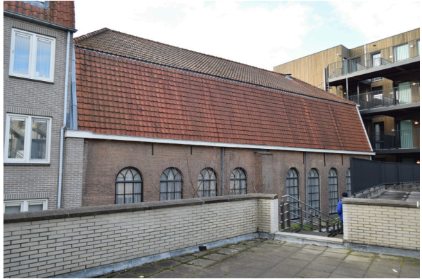
Overzicht van de achtergevel.
