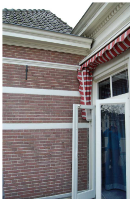
Aansluiting van de kroonlijst van het aan het eind van de negentiende eeuw verhoogde achterhuis op de achtergevel van het hoofdhuis.
